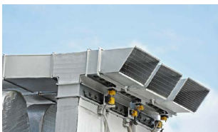
Rökutsugsfläktar / rökluckor
