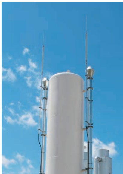
isCon®-systemet i utblåsområdet för en biogasanläggning
