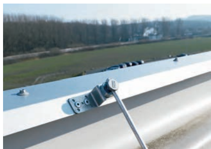
Anslutning av krönplåt till åskskyddssystemet
