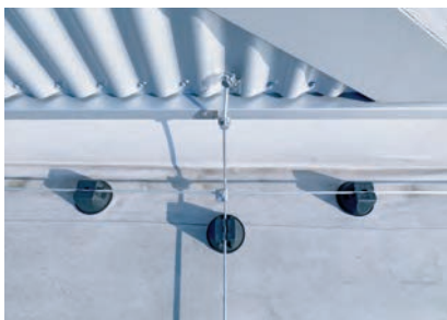
Anslutning av metallfasaden till åskskyddssystemet
